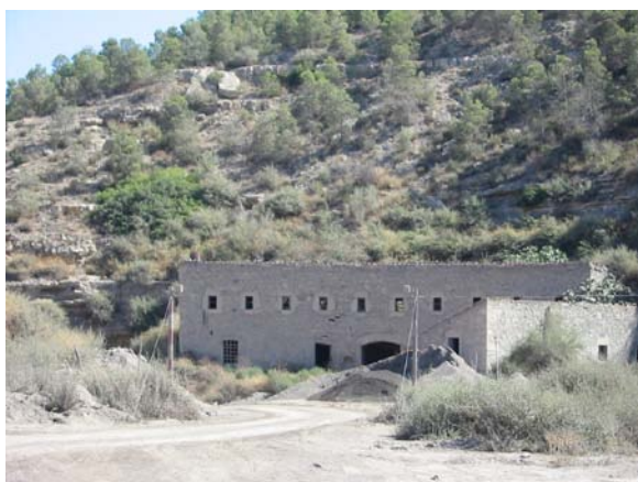
Foto 1. Instalaciones exteriores de la actual Mina Canota Separada.
