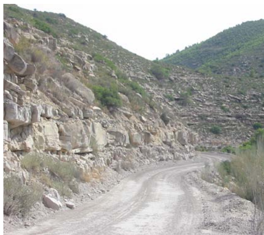
Foto 8. Tramo del ferrocarril entre el descargadero de la Mina Cloratita y el Ebro.
