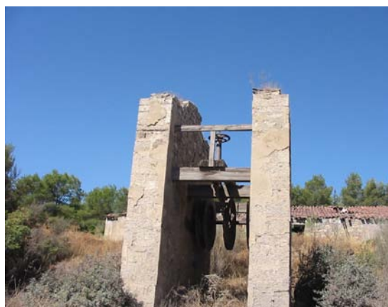
Foto 2. Restos de las poleas que hacían subir y bajar las vagonetas de la mina, por un plano inclinado. Al fondo los establos de los animales.
