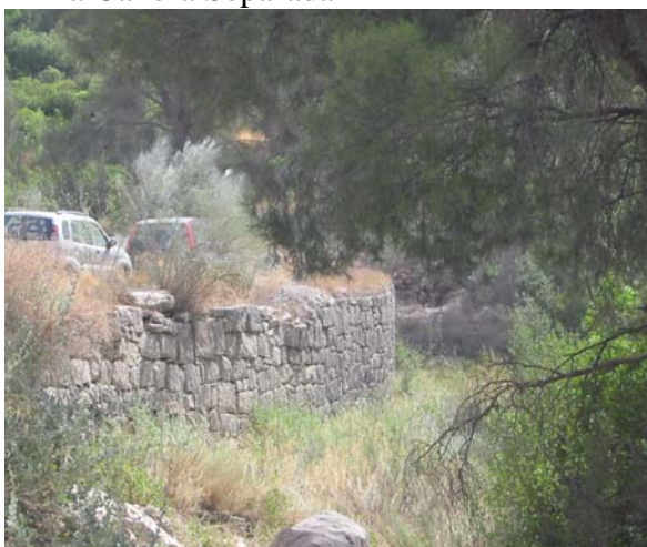
Foto 7. Muro de base del ferrocarril.
