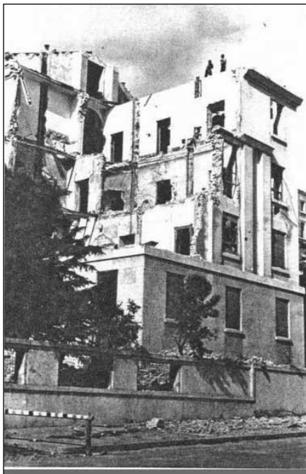
Figura 5. - I danni causati all'Istituto dal bombardamento del 19 luglio 1943.
