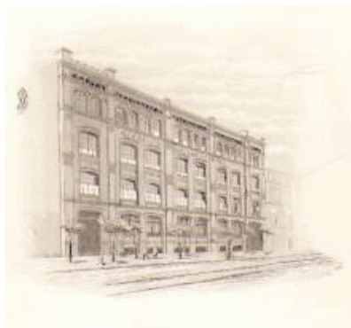
Grabado del frente del edificio.
