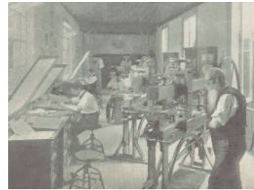
Sala de transferencia de planchuelas a rodillos
