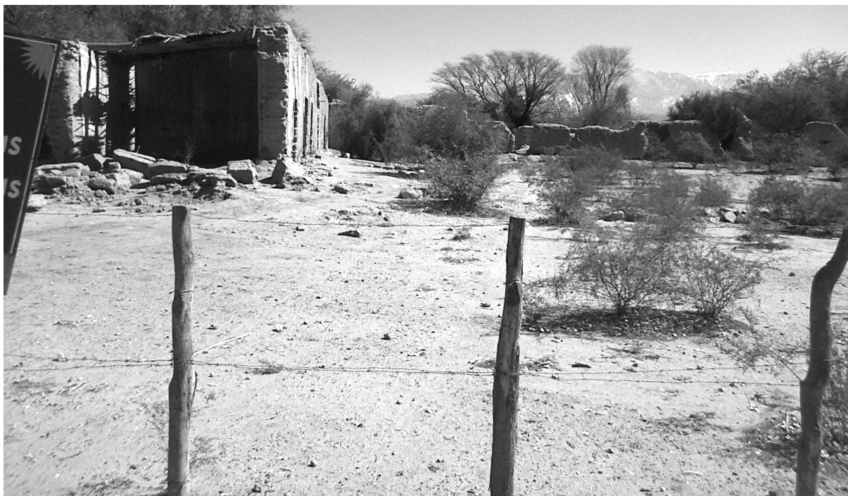
Ruinas de la edificación donde probablemente se acuñaron las monedas - 2015
