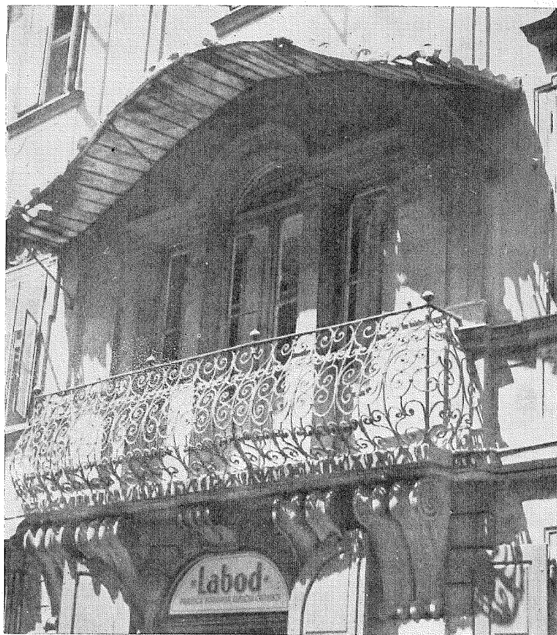
Сл. 10. Балконска испреплетана балустрада у Љубљани (Снимио Н. Шуми) Fig. 10. Balkon Korbgitterbalustrade in Ljubljana (Photo N. Šumi).
