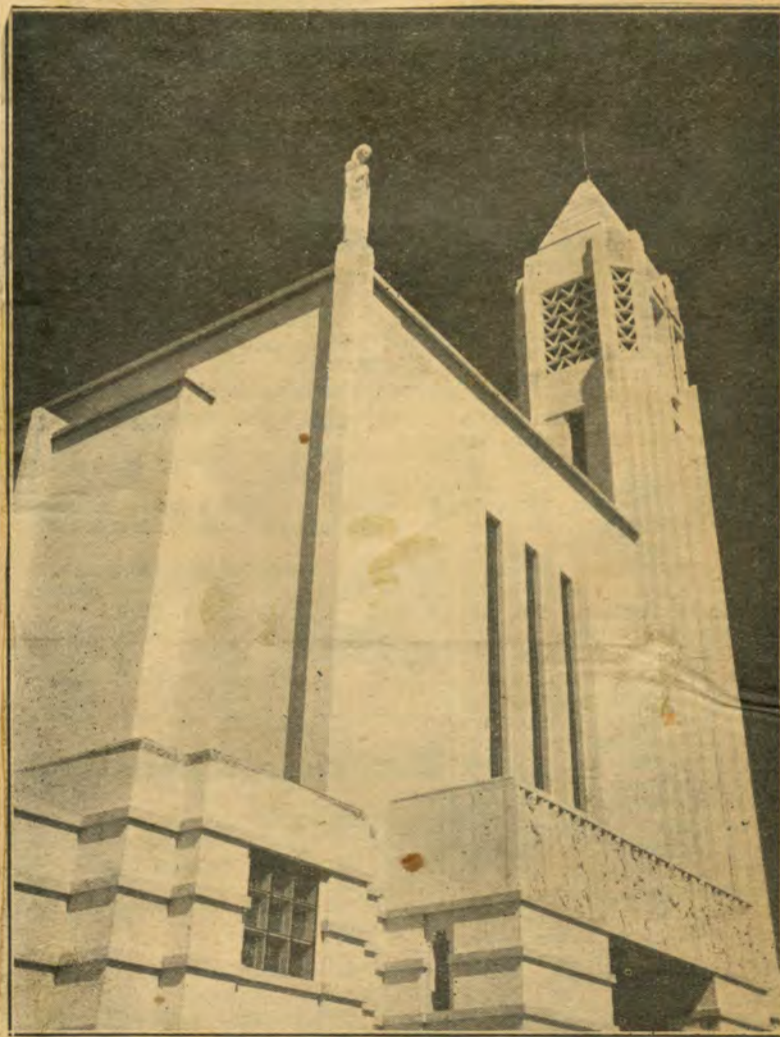
Numa das mais modernas avenidas ergue-se a nova Igreja da Nossa Senhora de Fatima. Obra arrojada da arquitectura moderna
