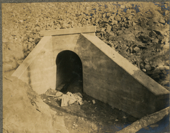
6' Skew Arch Sta. 420
