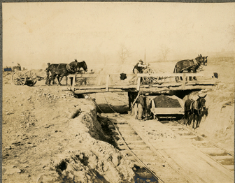
30000 cy Cut Sta. 590
