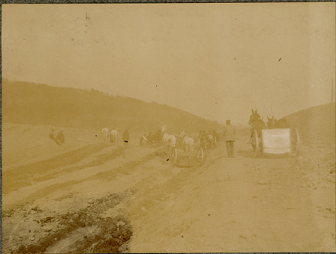
Borrow Pit - 60000 cu Yds Fill Sta 490
