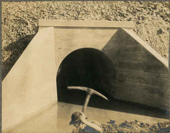
10' Concrete Arch Sta. 440
