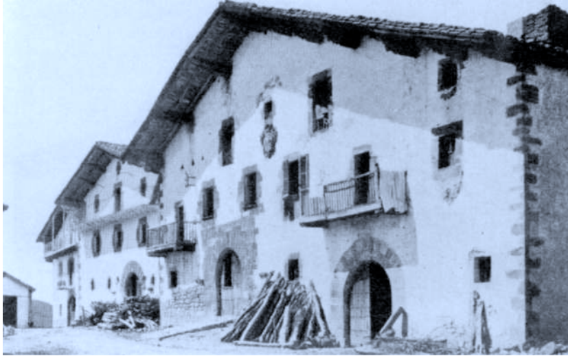
Arraiz (navarra). Grupo de casas de labranza Obsérvese que el portalón ha cedido el puesto al portal que caracteriza la casa de labradores dentro del pueblo.
