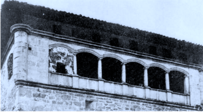
Gordejuela (Vizcaya). El caserío-torre Oxirando. La solana
