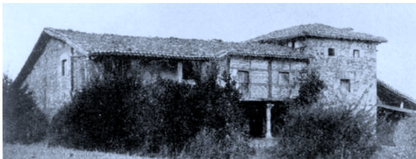
Larrea (Alava). Caserío del Bolo. Vista de conjunto
