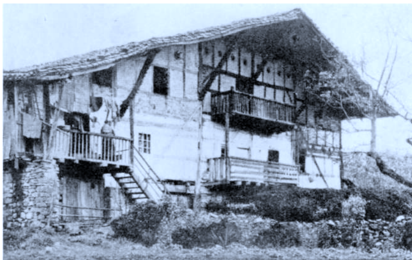
Ceberio (Vizcaya). Caserío Arene en el barrio de Arilza
