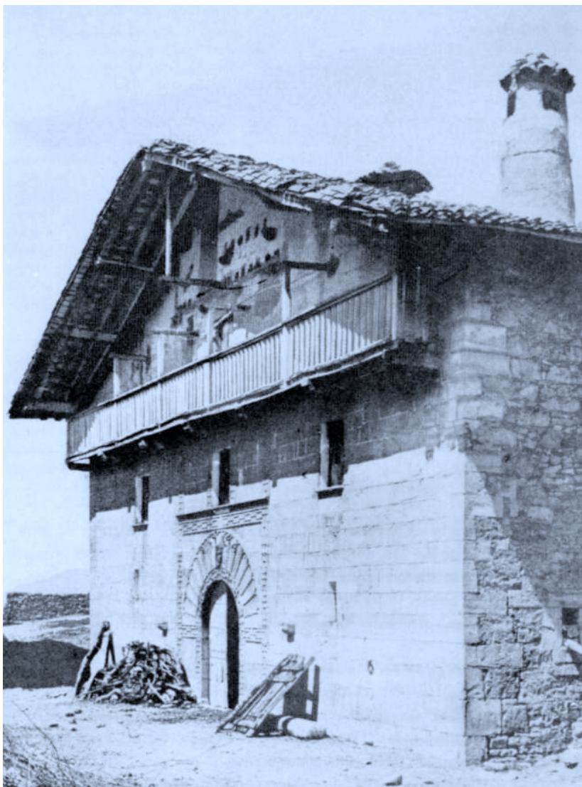
Guelbentzu (Navarra). Caserío. Vista de conjunto Posee esta casa el típico escape de humo de planta circular frecuente en Navarra y Aragón.
