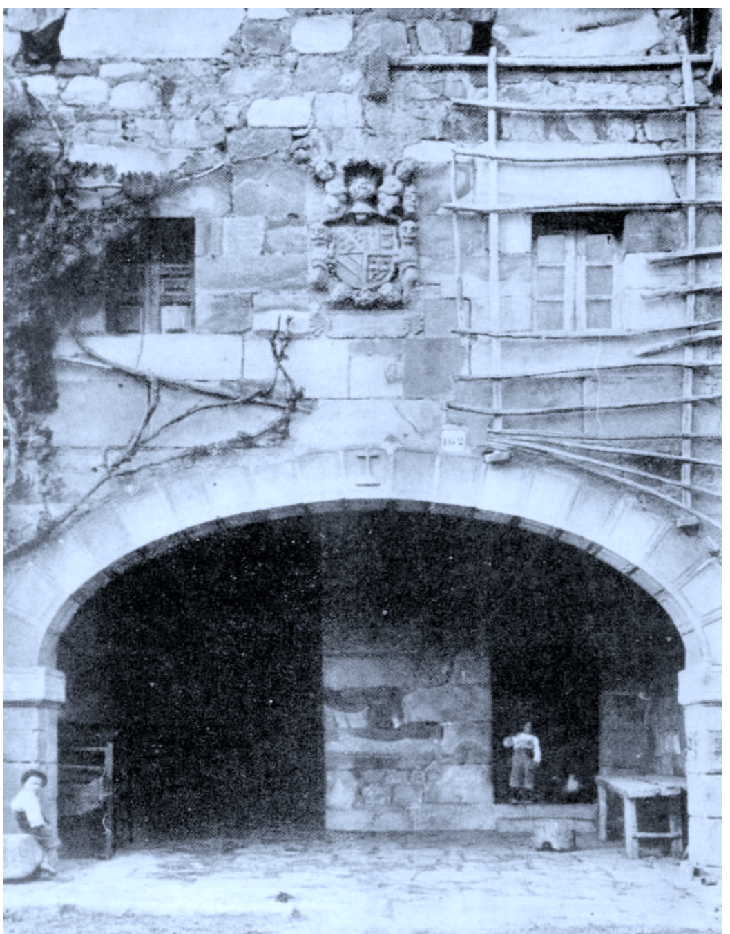
Gaztelua (Vizcaya). El portalón del caserío Iturriaga
