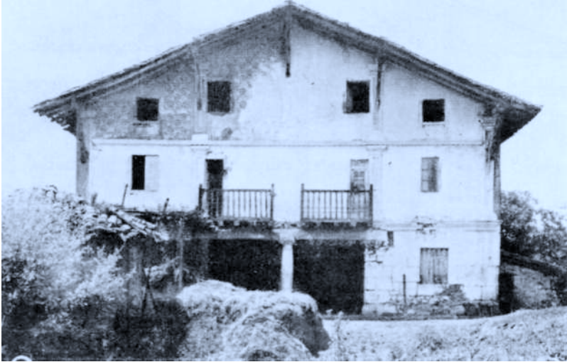
El Caserío Olasarra en el barrio Garaiolsa de Lezama (Vizcaya) Ha sido objeto de una reforma con intento de crear una fachada clasicista
