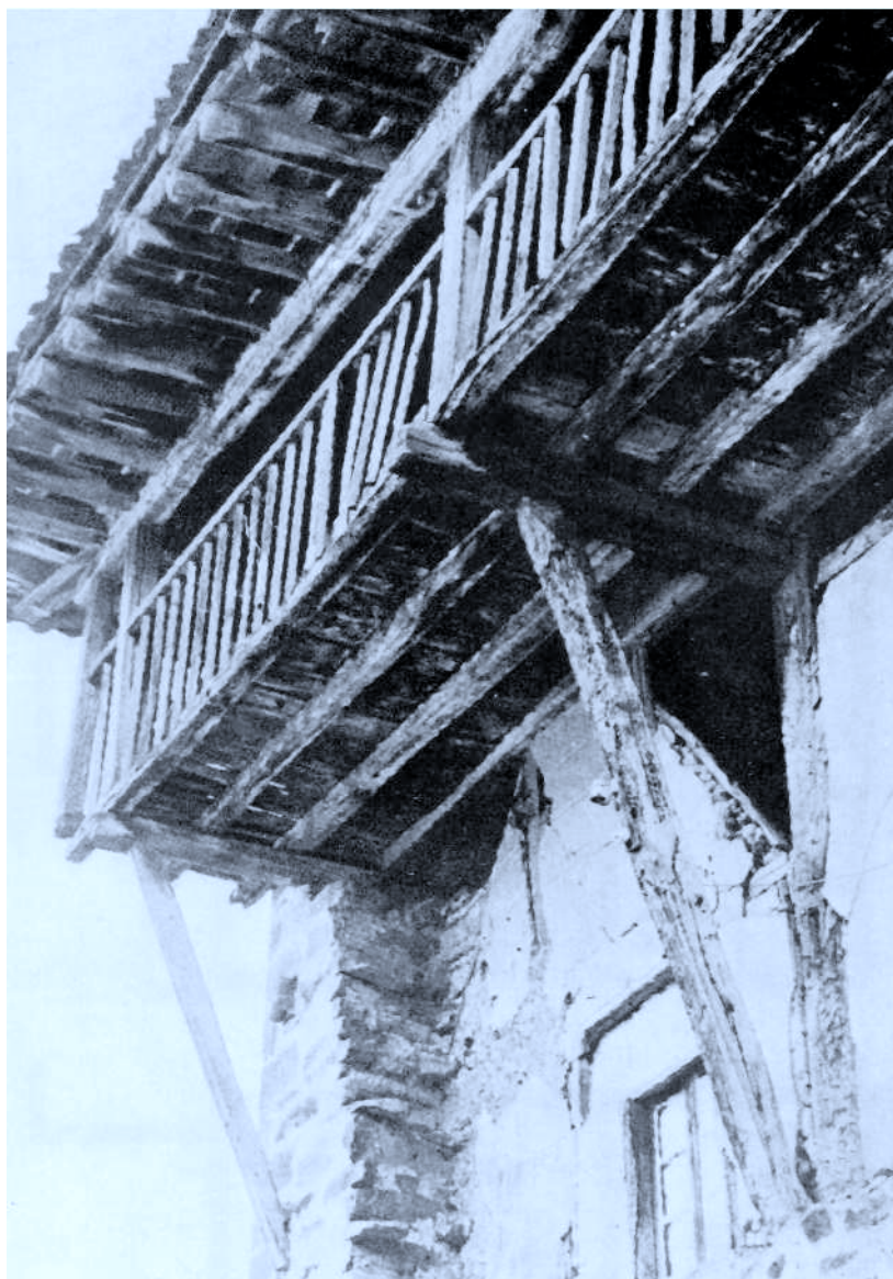
Gordejuela. Detalle del caserío El «Pontón»
