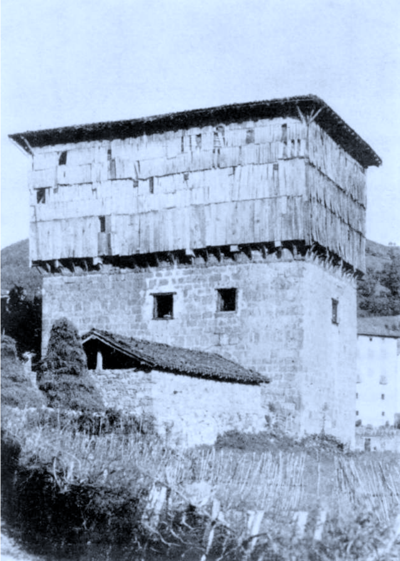
Donamaria (Navarra). Casa-torre con superestructura de madera
