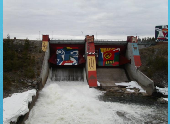
Hydropower Dam outside Jokkmokk ( Jokkmokk (odeblom.de) )
